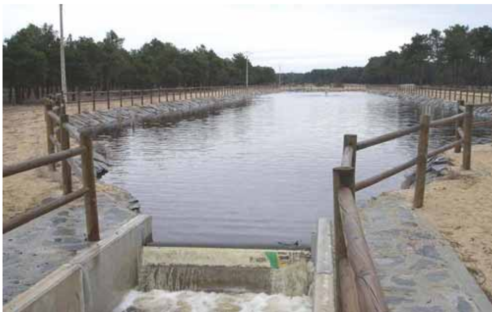
Figuras c-3 c). Aspecto de la balsa de decantación de Gomezserracín, de donde parten los canales que se dirigen hacia el Este (zona almacén).
