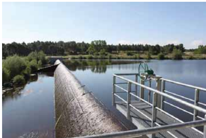
Figura s-1 c). Aspecto de la presa de retención en el río Voltoya para la recarga artificial de la Cubeta de Santiuste.
