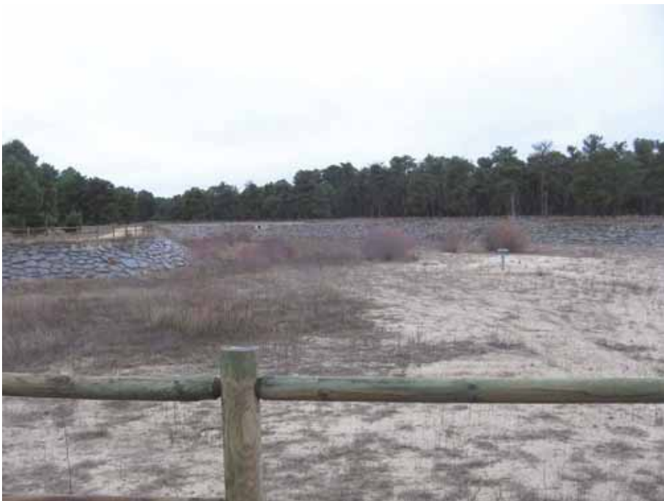
Figura c-2 c). Aspecto de la balsa de decantación e infiltración con una surgencia del sistema de tuberías de conducción desde el río Cega de donde parten algunos de los canales de Narros de Cuéllar.
