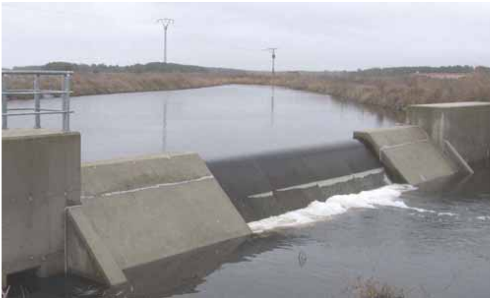
Figura c-1 c). Presa en el río Pirón tras la confluencia con el Malucas. Conviene destacar que esta presa, además de retener agua, condiciona el nivel de base de las aguas subterráneas del acuífero, que en este tramo es perdedor (cede agua al río).
