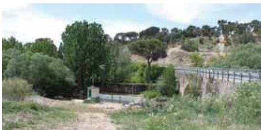
Figura s-7 c). Aspecto de la estación de aforo de Coca de la CHD, junto al río Voltoya y al Puente Chico de Coca.
