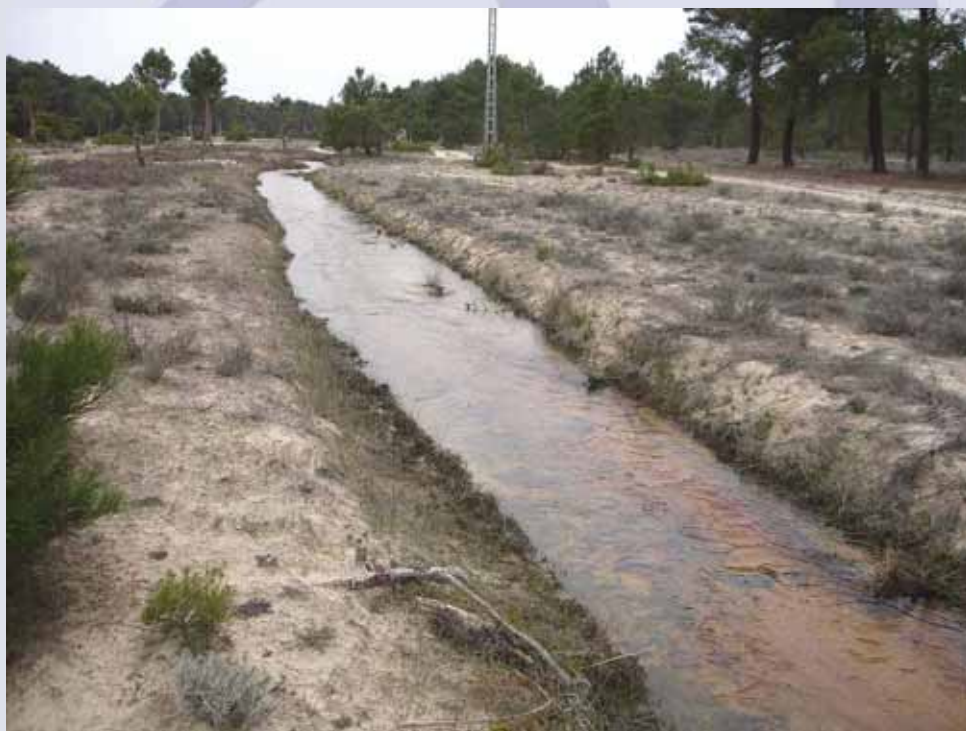
Canal de gestión de la recarga a la salida de la balsa de decantación de Gomezserracín (Segovia).
